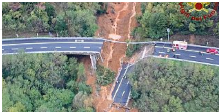
Sulla A6 Un tratto di viadotto Madonna del Monte sulla Torino-Savona è stato spazzato via da una frana, domenica scorsa
